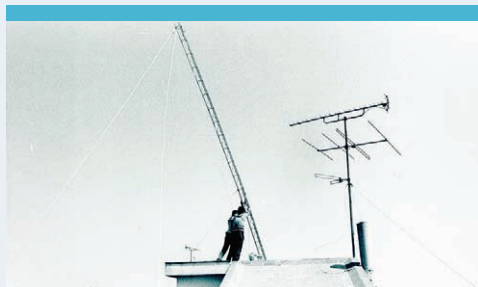
Instal·lació de la torre de Ràdio Vilafranca a l'edifici de l'Ateneu (1982)
